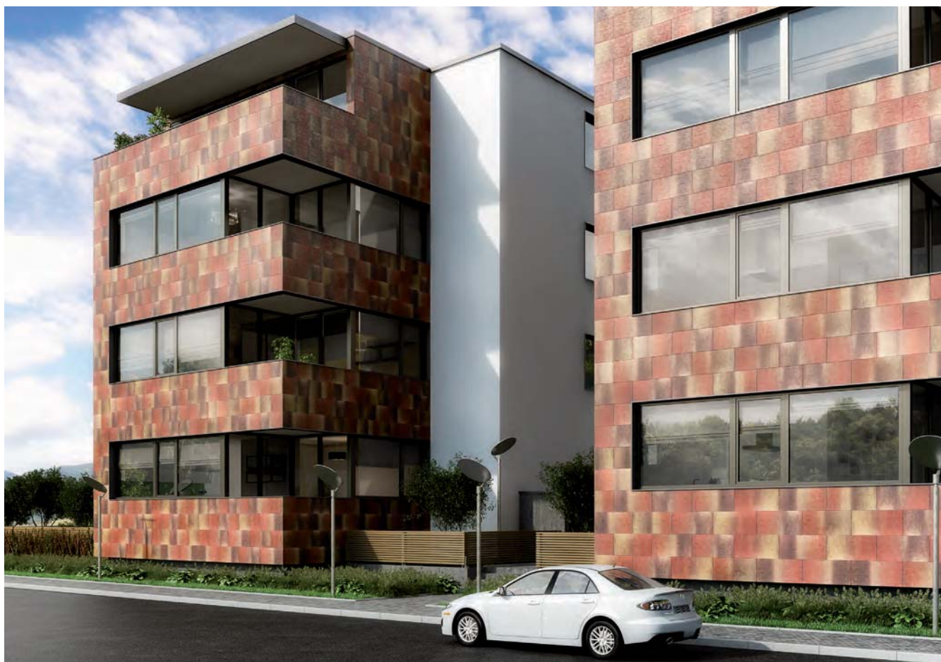
Obkladová fasádní deska – Korodo
